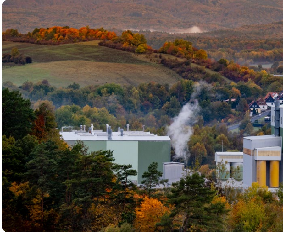
Abb. 4.1.: CASEA Gipswerk in Ellrich, Südharz
